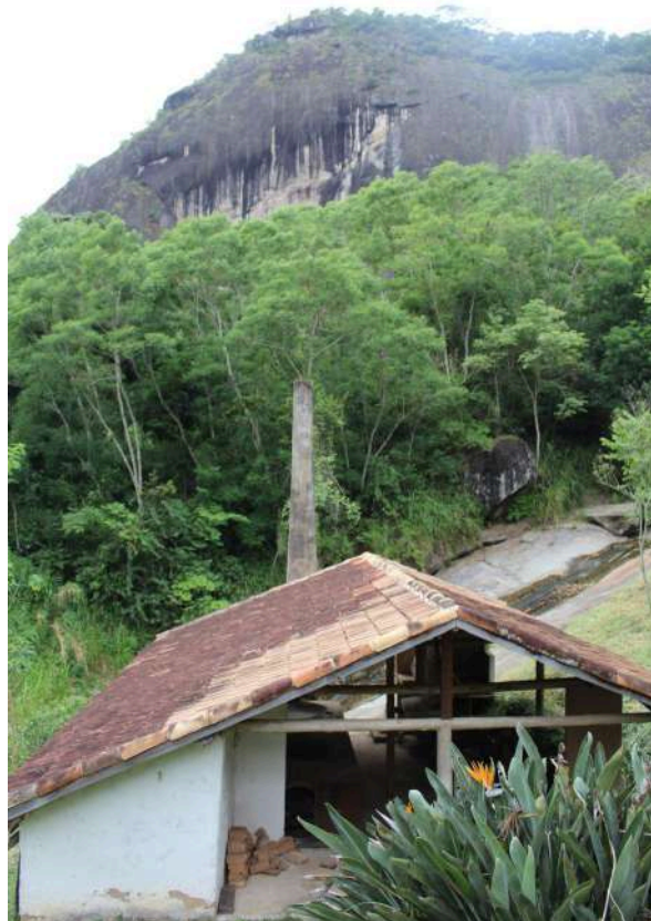
Figura 18: Estrutura do engenho com o relevo local compondo a paisagem
